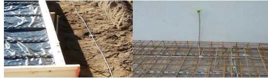
Şekil 9: Beyaz tekne metodu Halka topraklamanın genişleme direnci:
